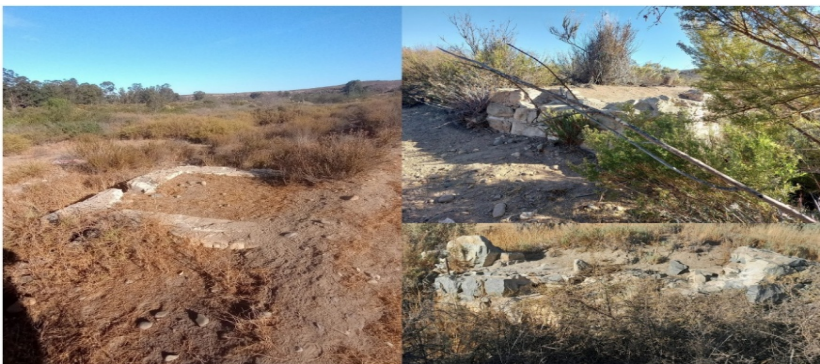
Figura 4: Cimientos de la estación y del puente que pasaría el tren. Fuente: Elaboración Propia.
