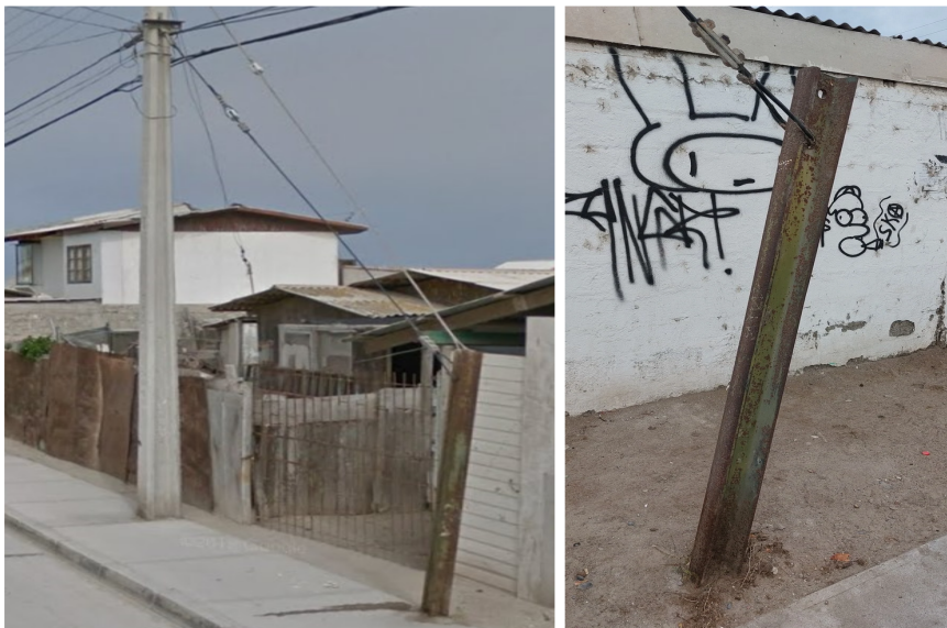
Figura 7: Reutilización municipal de rieles en Tongoy. Fuente: Elaboración propia.
