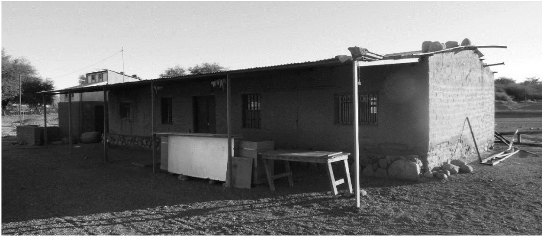
Foto 3: Sede del Huracán, ubicada al costado oeste de la cancha (2017). Es utilizado como comedor y camarín. Cuenta con una cocina, baño y una pequeña bodega. Fuente: Elaboración propia.
